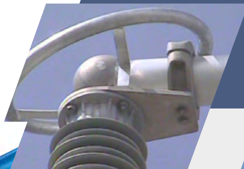
Efecto corona no detectado tal como refleja la simulación de efecto corona realizada.
